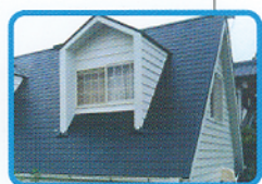
屋根：スレート屋根
