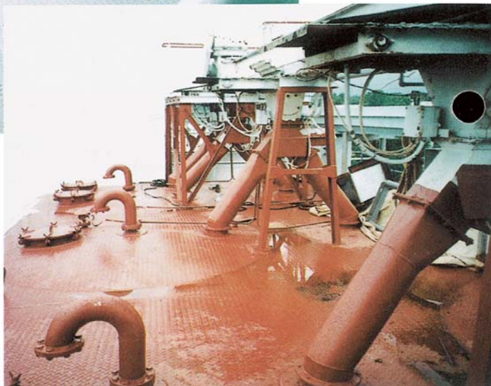
エポンマイルドプライマー下塗り
